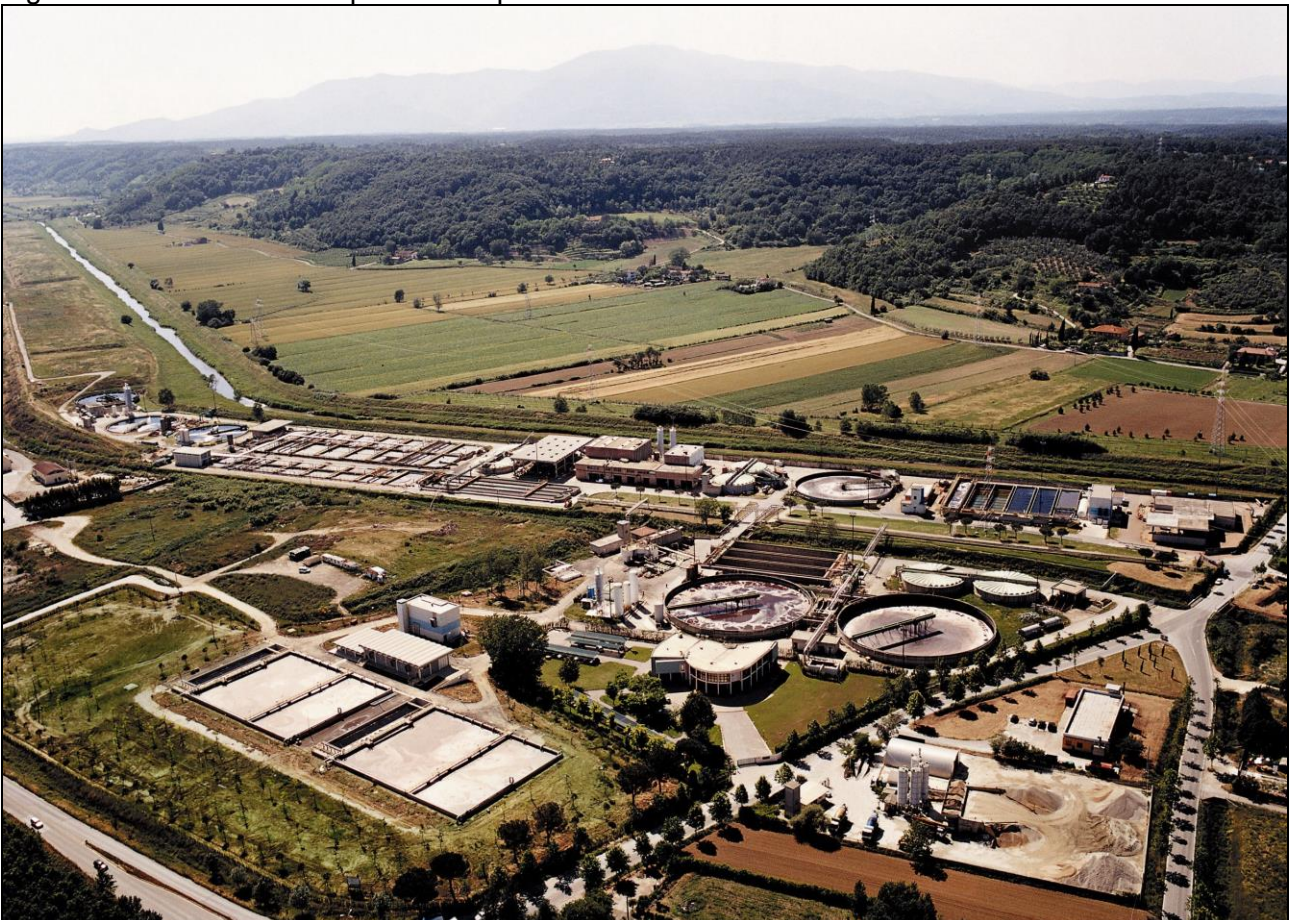
Figura 2. Panoramica depuratore Aquarno.
