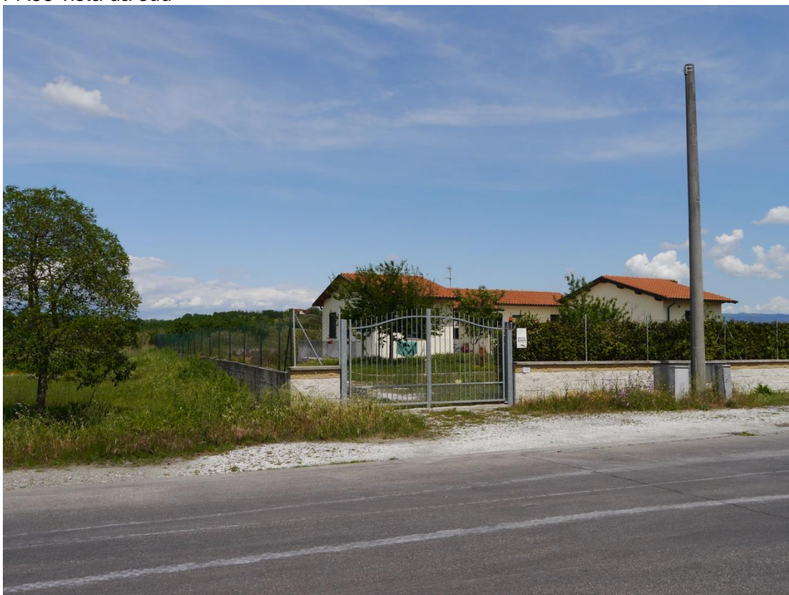
PA58 vista da sud
