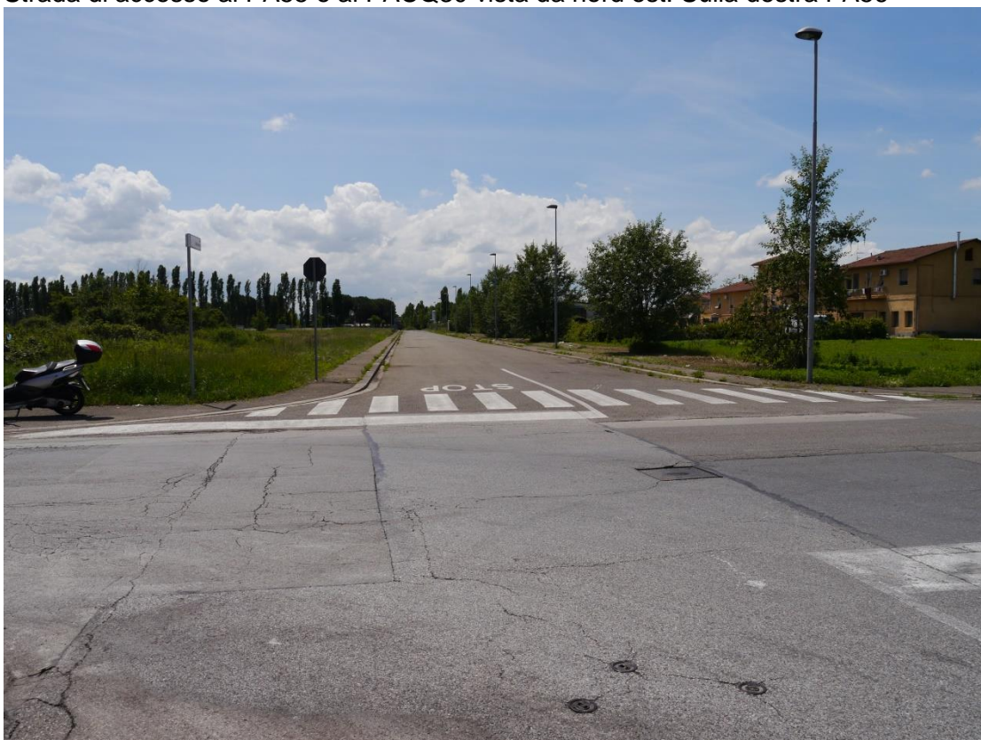
Strada di accesso al PA55 e al PACQ30 vista da nord est. Sulla destra PA56
