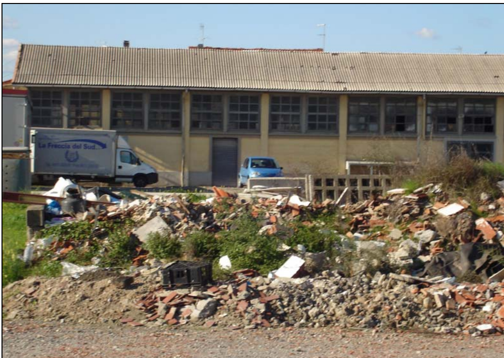
Presenza di cumuli, macerie e altri materiali ingombranti in corrispondenza del futuro LOTTO C
