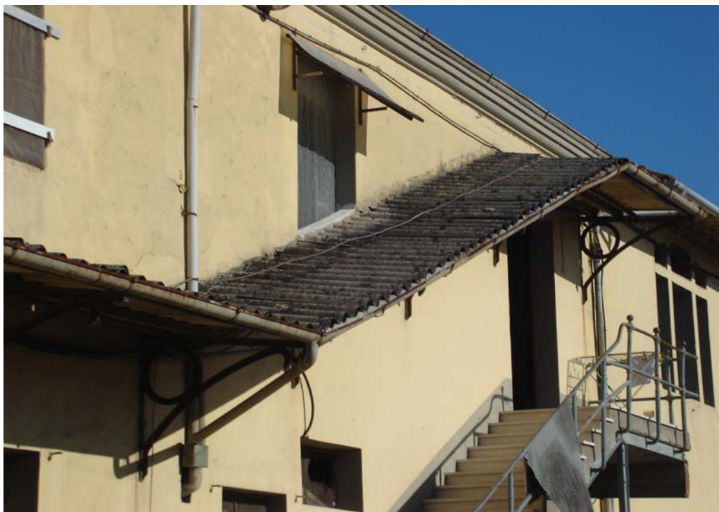
Tettoia in eternit in corrispondenza al futuro LOTTO A
