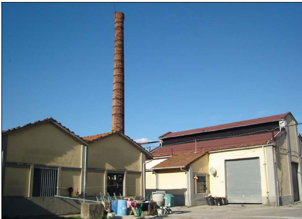
Stato attuale della ciminiera e dei manufatti contigui
