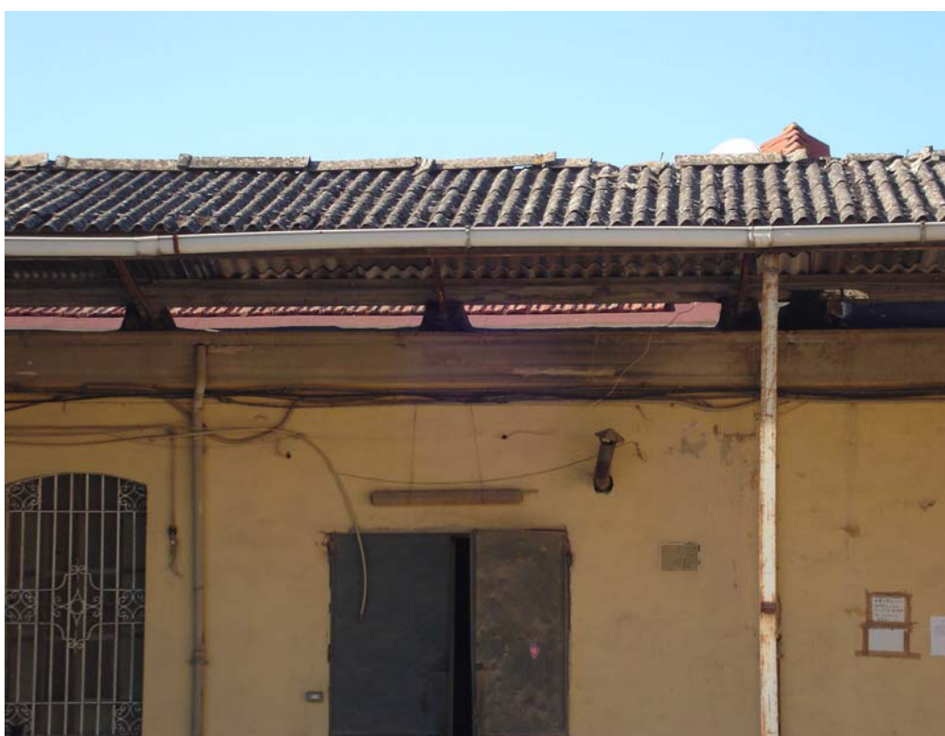
Copertura in eternit in corrispondenza al futuro LOTTO A
