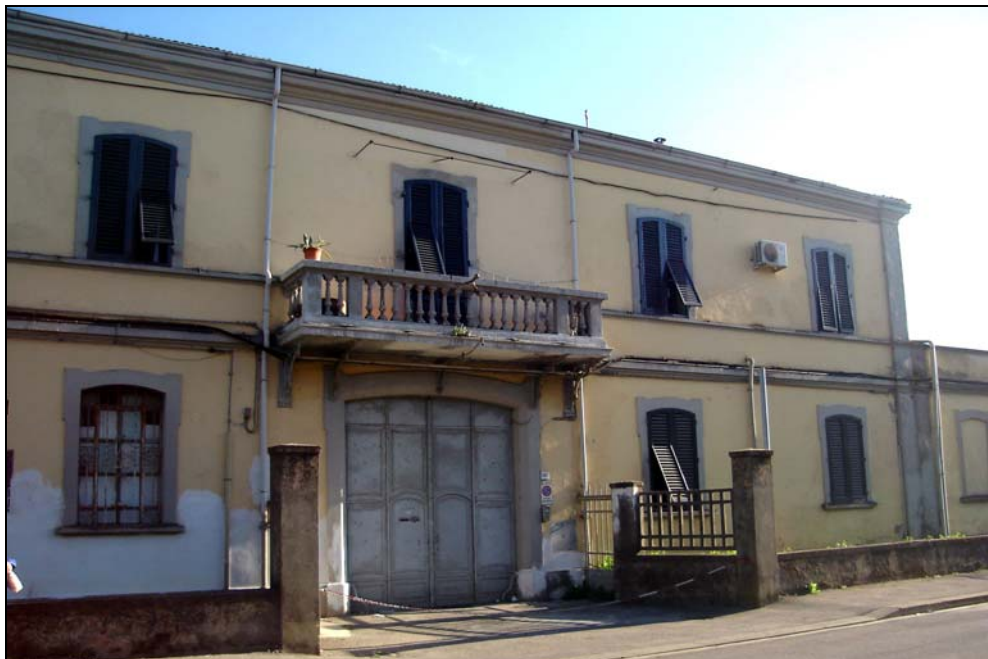
Stato attuale della facciata della ex- fabbrica "Saffa" prospiciente Via Dante Alighieri e facente parte del futuro LOTTO A
