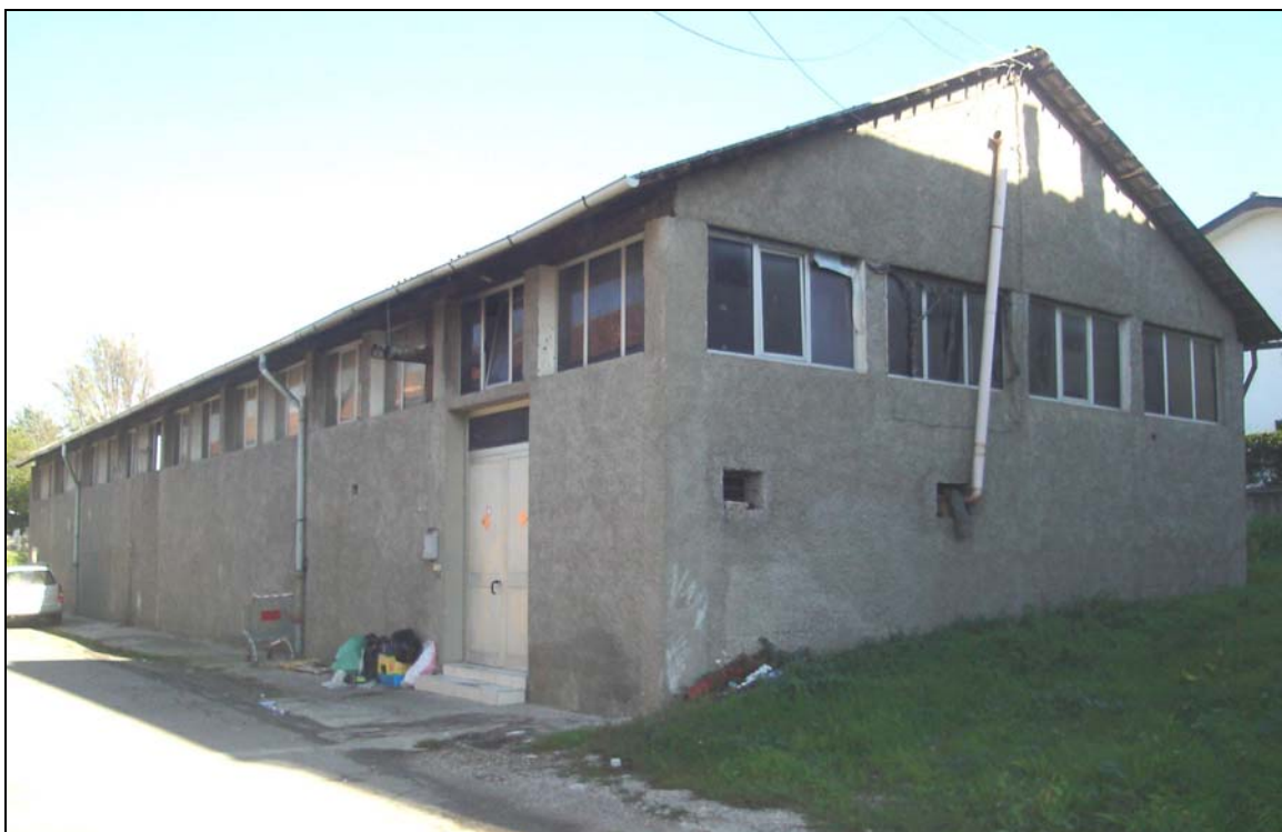
Manufatti con coperture in eternit in corrispondenza al futuro LOTTO E-F
