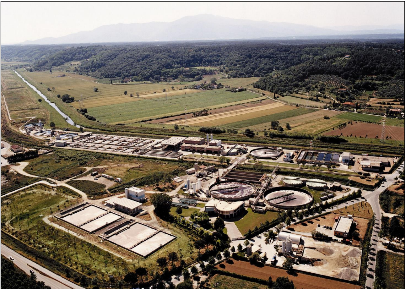
Figura 6. Panoramica depuratore Aquarno.
