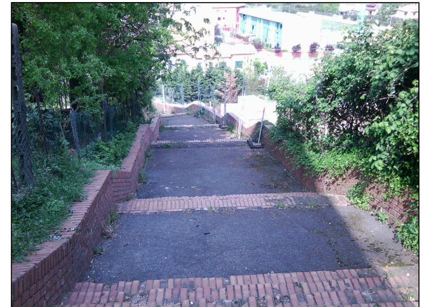
F18 - Via Bracci
