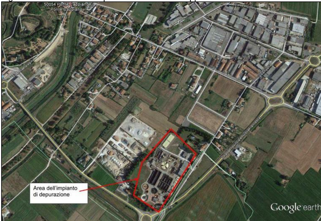
Figura 4. Panoramica depuratore di Ponte a Cappiano.
