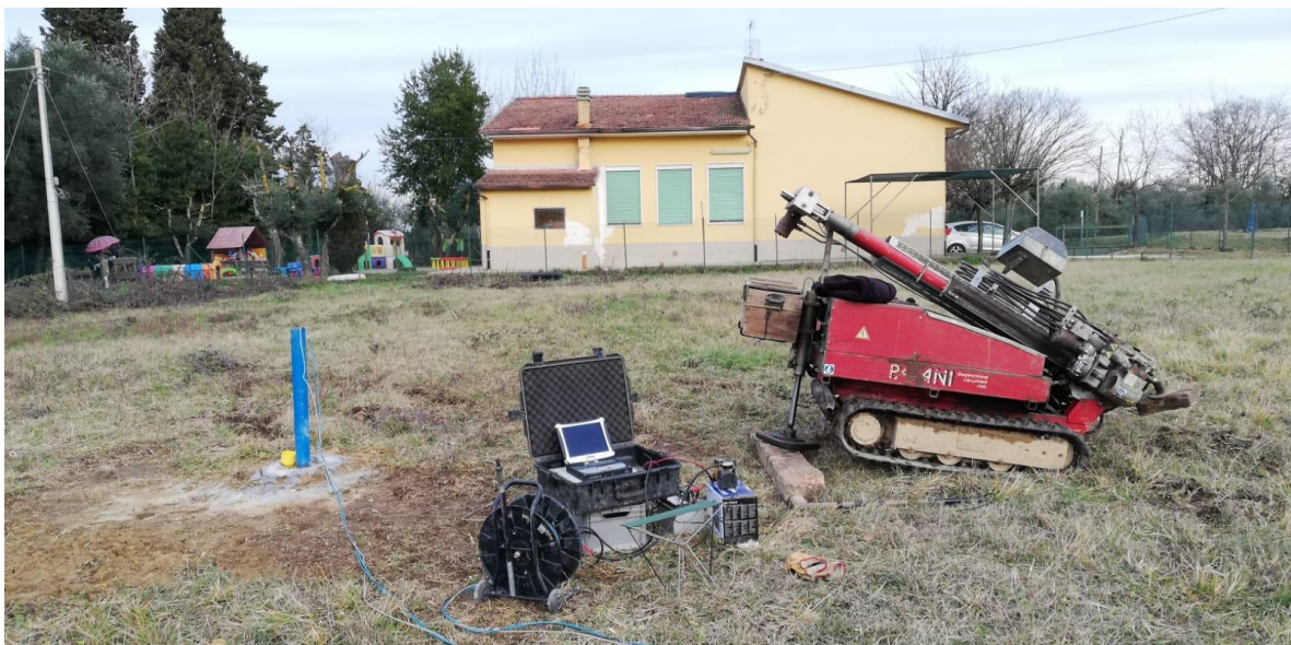
Figura 1: Indagine sismica Down Hole
